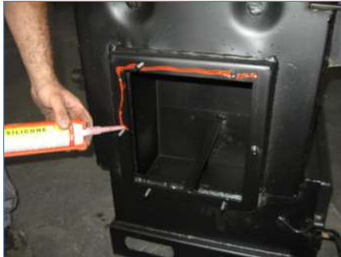
Малюнок 29. Нанесення жаростійкого силікону перед встановленням прокладки.
