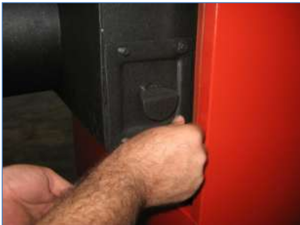
Малюнок 17. Зняття заглушки для чищення адаптера диму
