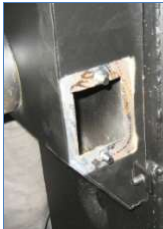
Малюнок 18. Отвір для чищення адаптера диму
